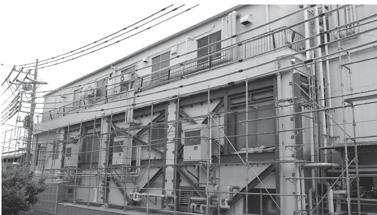
工場の耐震補強工事
