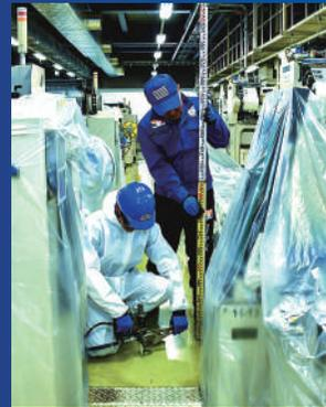
アップコン工法は既設床を壊さない施工です。機械や商品の移動や代替スペースの確保も不要です。操業・営業を止めずに施工することでトータルコストの削減を可能にします。
