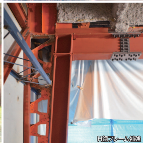
アウトフレーム補強
