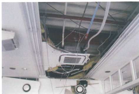
地震によって内装壁が崩壊
