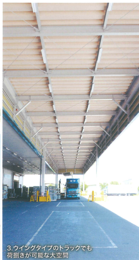
2. 強度に優れた6本の柱を設置し、トラックが出入りしやすい荷捌きスペースに
