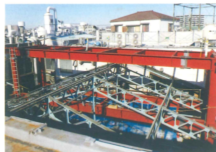
エビナ電化工業 株式会社 様 ●ももとの建物の柱と梁を残すことにより、建築確認にはあたりません。
