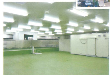
有名お菓子メーカー 様 ●居抜き倉庫を改修して、内部の耐震補強と食品工場としての機能を入れる。(内装の改修なので建築確認不要)
