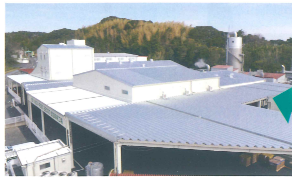
●工場建屋どうしを巨大な庇で覆い工場全体を一体化。雨天時の工場間移動問題、作業の効率化に帰依した。
