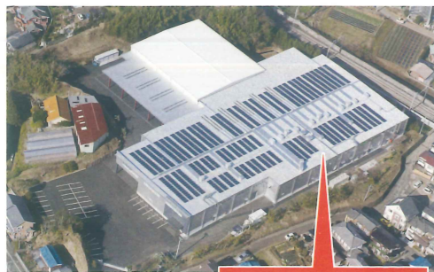
屋根全面に太陽光パネル
