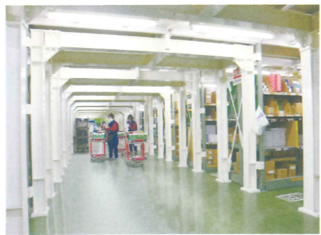
トヨタ部品神奈川共販 株式会社 様 ●耐震フレームを回廊状に建て、従業員の安全とラック棚の固定を同時に確保。
