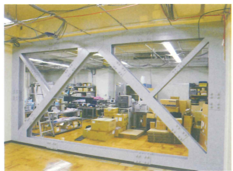
株式会社日放電子 様 ●工場の内部から耐震補強を行い、地震に強い工場として、災害時にも安定供給出来る事をアピール。
