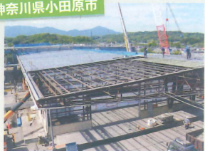
(株)フジダン様 カバービルド(かぶせ工法)
