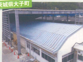
金属加工業様 カバービルド(かぶせ工法)
