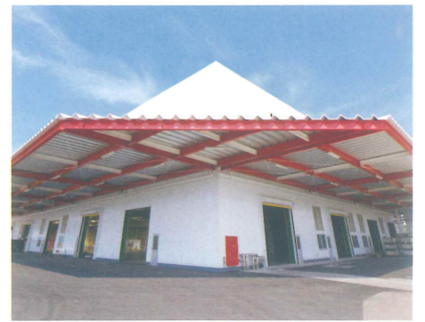
●吊り構造の巨大庇でどこからでもトラックの出入りを可能にし、作業効率の大幅アップに成功。
