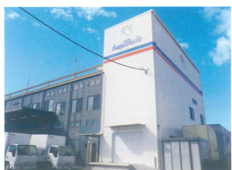
エンゼルフーズ株式会社 様 ●子供たちのための給食工場、安全で衛生管理が行き届き、かつ大量出荷が可能な工場へ変貌。
