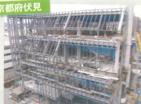
酒造メーカー様 カバービルド(かぶせ工法)
