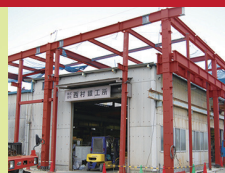
2. 強度に優れた6本の柱を設置し、トラックが出入りしやすい荷捌きスペースに
