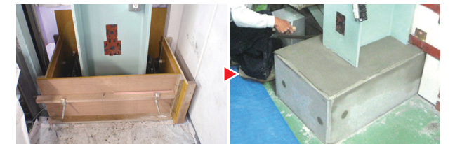
▲柱脚根巻き補強▲
