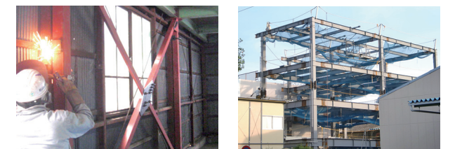
▲既存倉庫棟・耐震補強工事
