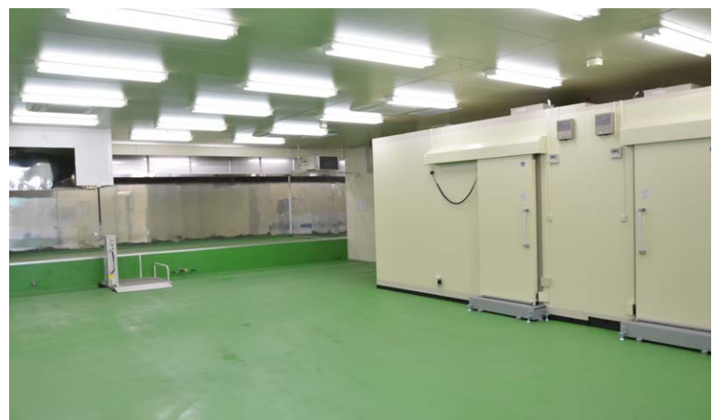
天井・壁・床を全面改修!
