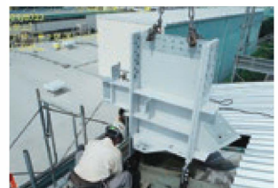
既存建屋の柱と嵩上げ部分の柱を接続
