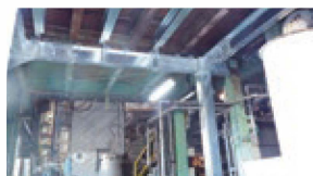
錆びに強いメッキ処理の部材を使用
