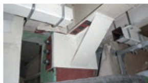
既存の架台を壊さず、補強部材を設置
