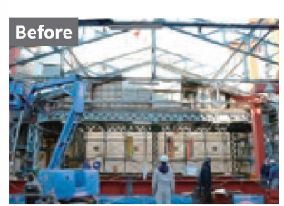
耐震フレームを取り付ける様子
