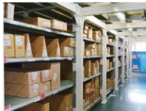
棚と上階の床を支える補強
