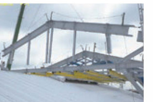
嵩上げる屋根を被せるように施工
