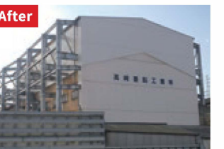
大型クレーンの設置・耐震補強後
