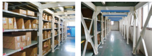
棚と上階の床を支える補強
