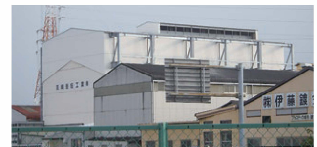
既存建屋の柱と嵩上げ部分の柱を接続
