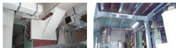
既存の架台を壊さず、補強部材を設置
