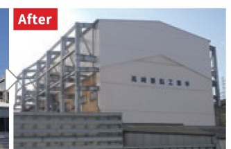
大型クレーンの設置・耐震補強後
