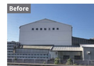
巨大めっき槽入れ替え・リノベーション前
