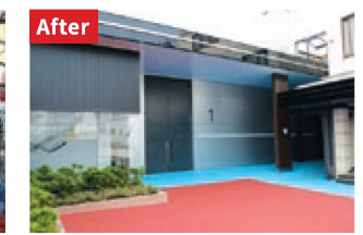
高さが揃い、外観にも統一感が出た
