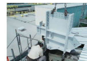
既存建屋の柱と嵩上げ部分の柱を接続
