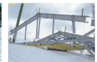
嵩上げる屋根を被せるように施工
